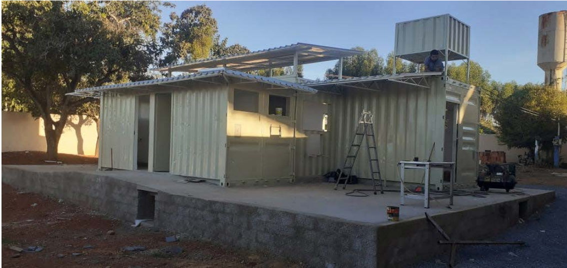
Construção da Unidade de Beneficiamento em forma de contêiner .
