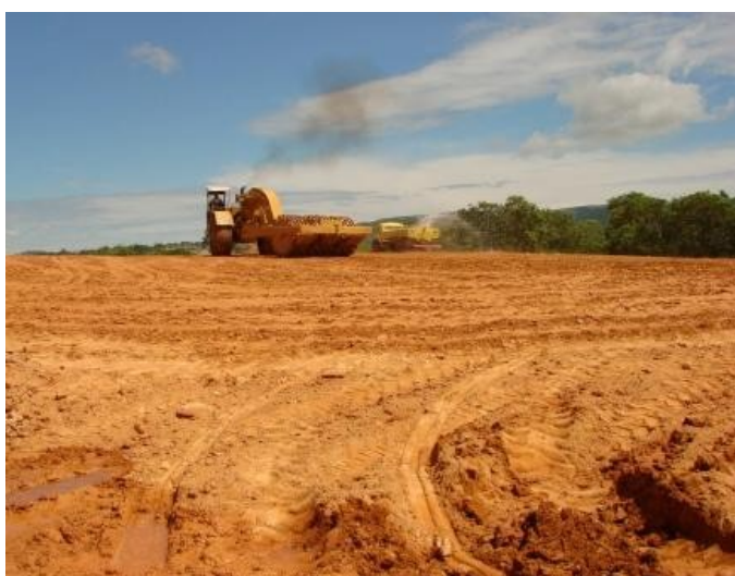
Fig. 61. Obras de duplicação da BR 040 no trecho Sete Lagoas – entroncamento com MG 050. Dezembro de 2007.
