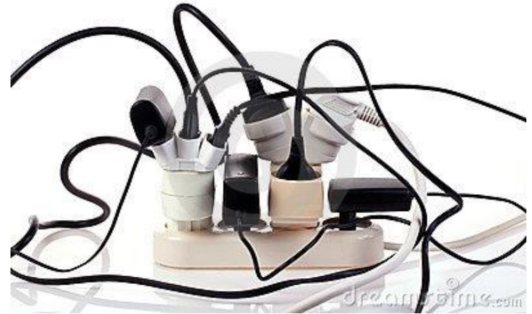
Sobrecarga nas instalações elétricas
