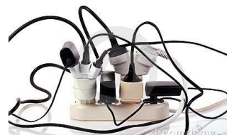
Sobrecarga nas instalações elétricas
